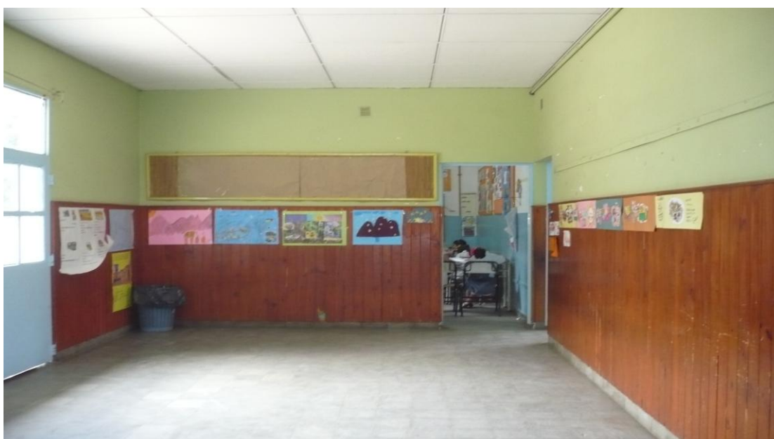
F8 VISTA DEL AULA .Esta aula se encuentra cerrando el paso de la galería lateral, se hizo de forma precaria por la falta de espacio, en el proyecto se plantea la extracción de los tabiques y la devolución de este espacio con una nueva aula.
