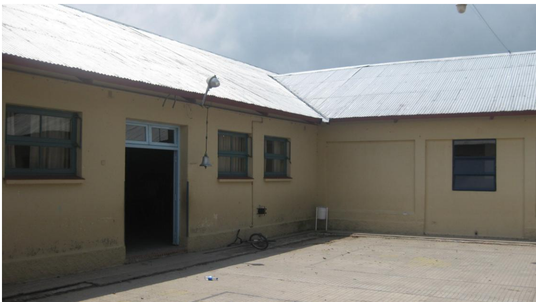
F2 PATIO INTERNO. Se observa el patio interno, el edificio se desarrolla en torno al mismo en forma de U.
