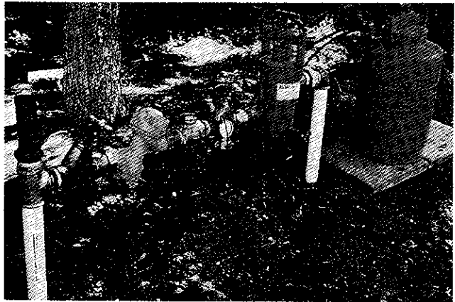
Foto 21. Cabezal de riego por goteo.
