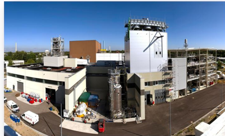
Fig. 6: La planta piloto bioliq en el KIT, Karlsruhe, Alemania. Desde la izquierda, preparación de la biomasa (trituration y molienda), pirólisis rápida, almacenamiento de biosyncrude , gasificación con flujo de arrastre, purificación del gas, síntesis de DME y gasolina.
