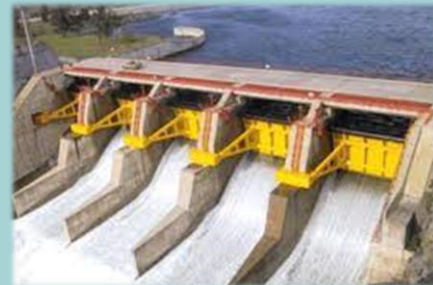
Complejo hidroeléctrico Río Grande, Córdoba.
