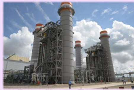
Central termoeléctrica de Pilar, Córdoba.
